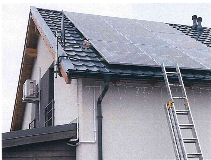
Fot. Montaż instalacji fotowoltaicznej
