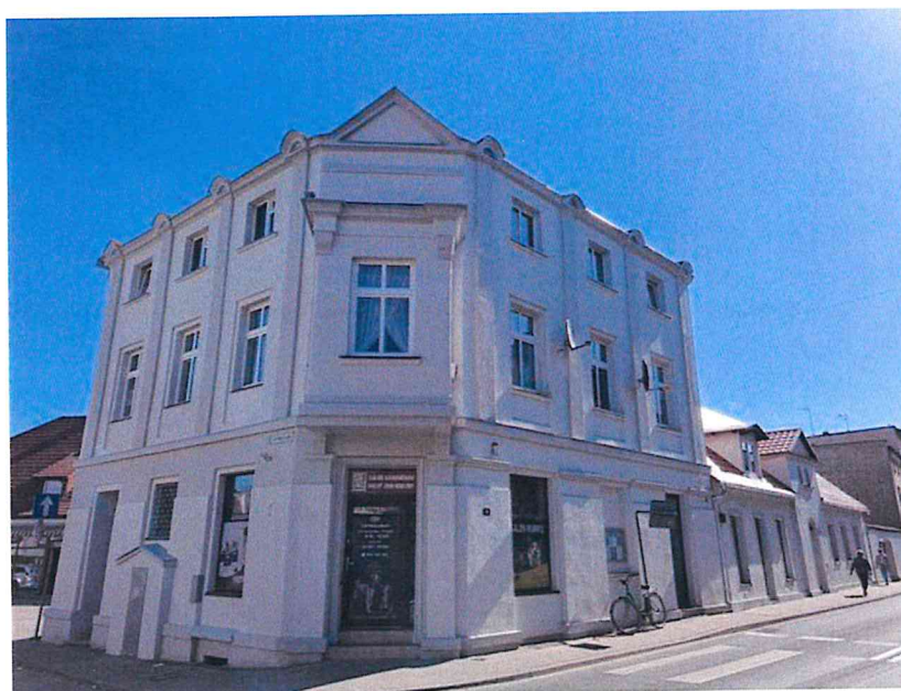
Fot. Wyremontowana kamienica na ul. Poznańskiej
