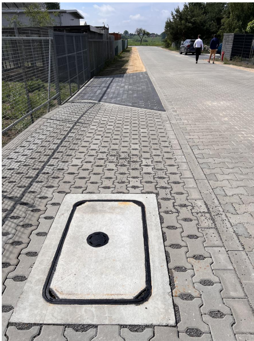
Fot. Remont – budowa drogi z kostki brukowej w Popowie.
