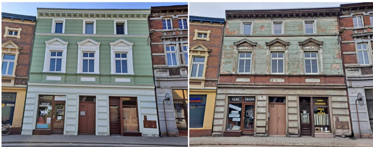
Fot. Remont kamienicy przy ul. Poznańskiej 12 przy wsparciu z gminnej dotacji.
