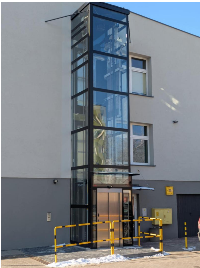
Fot. Nowa winda przy przychodni zdrowia przy ul. Partyzantów.
